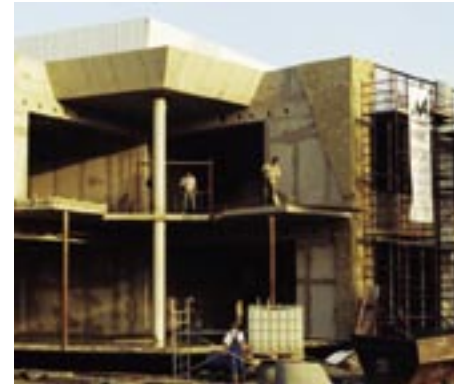
A Rittal Kft. telephelye építés közben, és a végeredmény. Az impozáns épület irodákkal, 2000 EUR raklapos raktárkapacitással szolgálja a vevők kényelmét.
